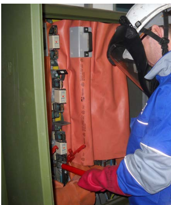
Abb. 18 Wechsel einer Sicherungsleiste im Schaltschrank (nahe der Seitenwand): k_T = 1,0
