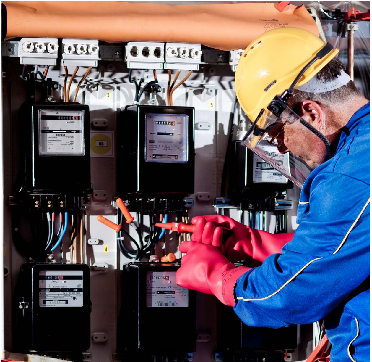
Abb. 14 Arbeiten hinter der Hauseinspeisung
