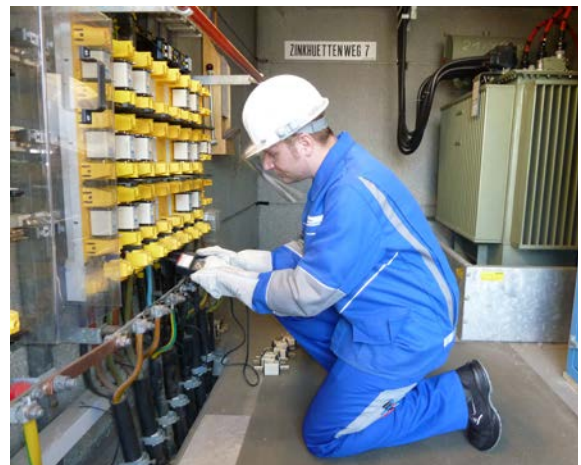
Abb. 8 Arbeiten an einer NS-Verteilung
