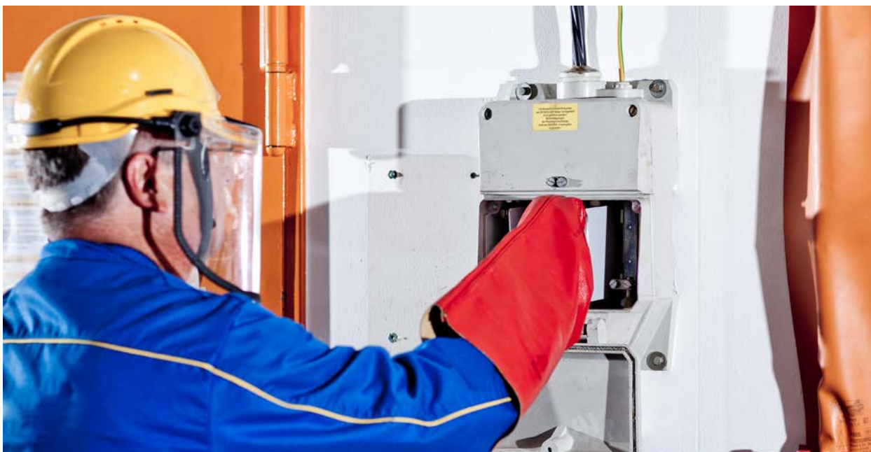
Abb. 17 Arbeiten am Hausanschlusskasten: k_T = 1,0
