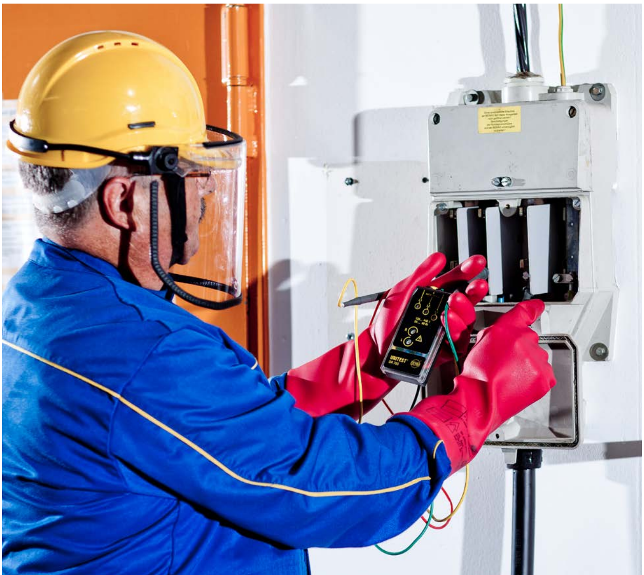
Abb. 13 Arbeiten am Hausanschlusskasten
