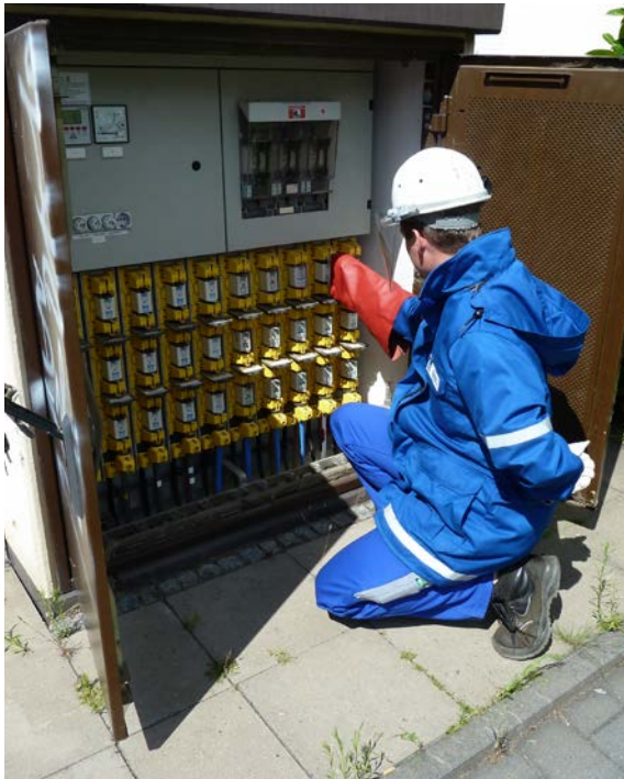
Abb. 20 Arbeiten an einer Kompaktstation: k_r = 1,7
