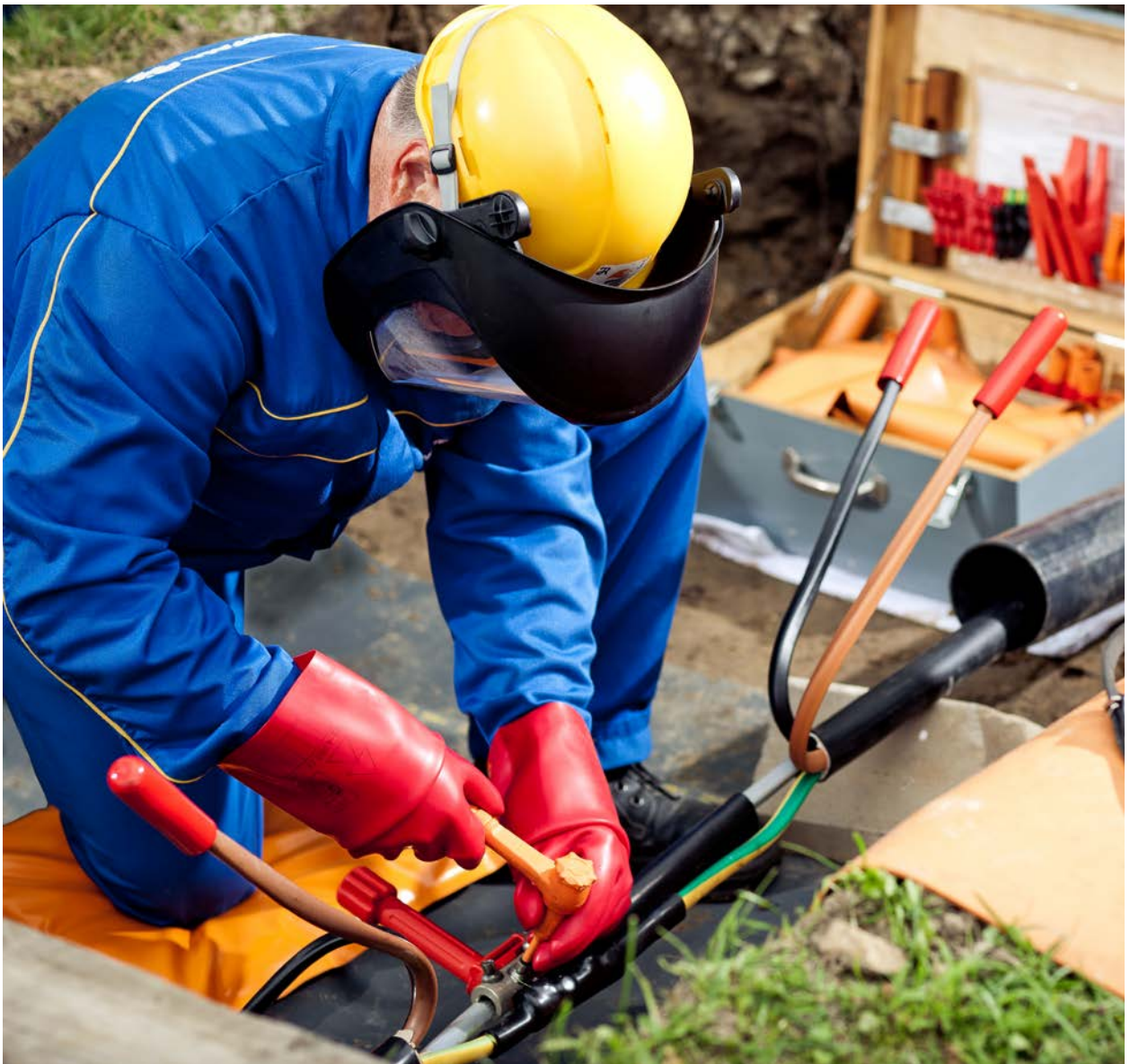
Abb. 11 Arbeiten an einer Kabelmuffe
