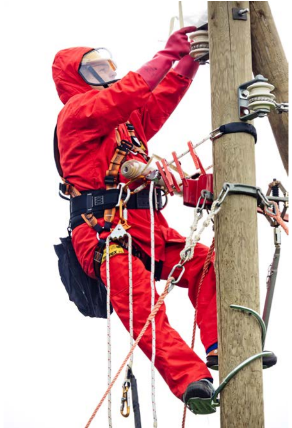
Abb. 22 Arbeiten auf dem Mast: k_r = 2,4
