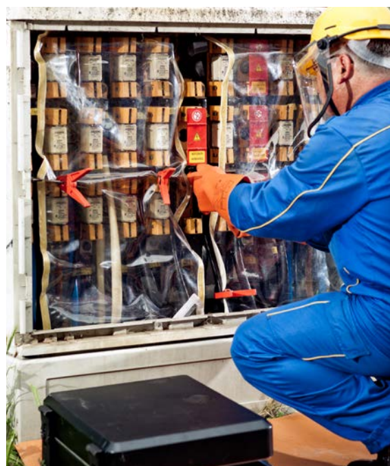
Abb. 19 Arbeiten am Kabelverteilerschrank: k_T = 1,5
