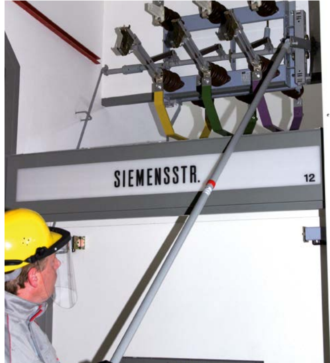
Bild 5-10: Elektrofachkraft beim Öffnen eines Hochspannungstrenners
