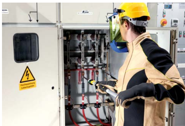
Bild 5-16: Feststellen der Spannungsfreiheit in einem Schaltfeld
