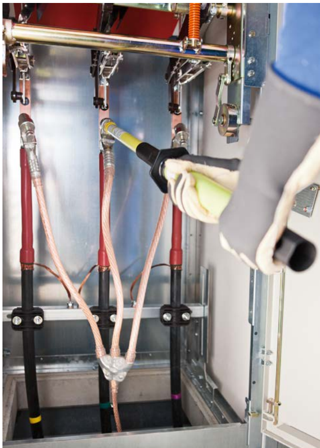
Bild 5-18: Erden und Kurzschließen nur mit kurzschlussstromfester Leitungsgarnitur
