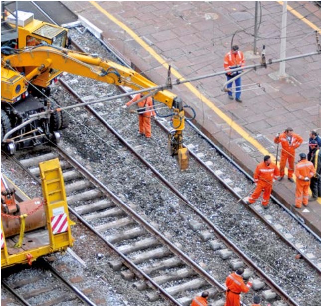
Bild 5-38: Arbeiten in der Nähe unter Spannung stehender elektrischer Anlagen
