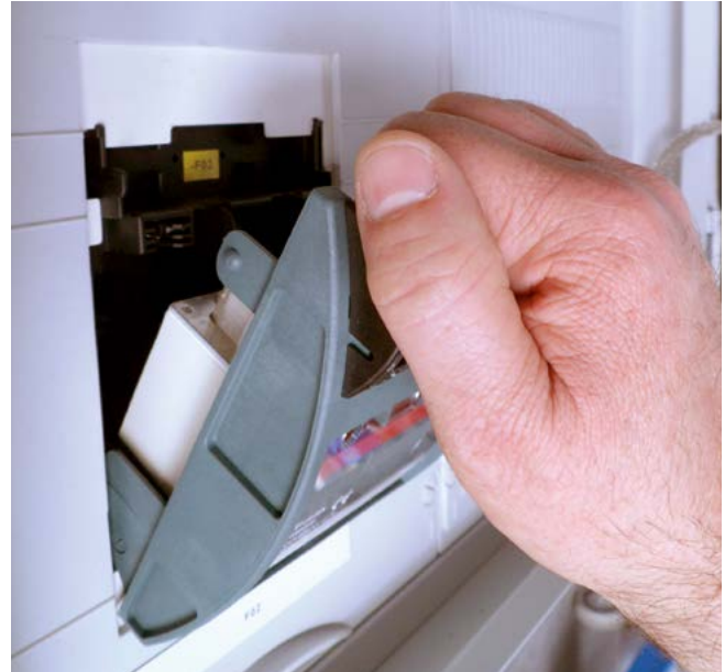
Bild 5-34: NH-Sicherungslasttrennschalter
